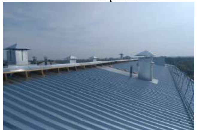
Состояние крыши МКД после проведения капитального ремонта
