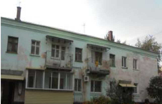
Состояние фасада МКД до проведения капитального ремонта
