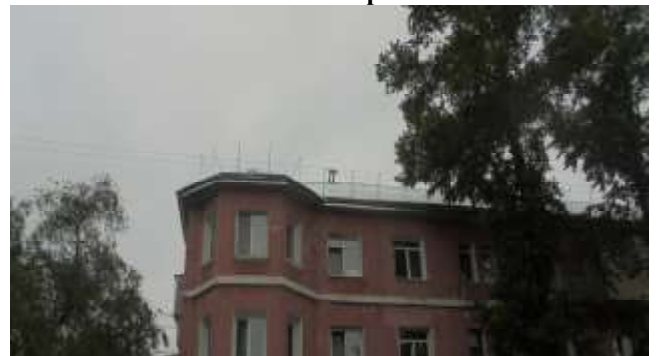
Состояние крыши МКД после проведения капитального ремонта
