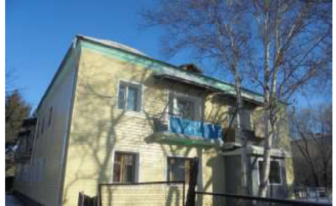
Состояние фасада МКД после проведения капитального ремонта
